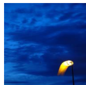
Sistema de Iluminación Estándar para Operaciones Nocturnas
